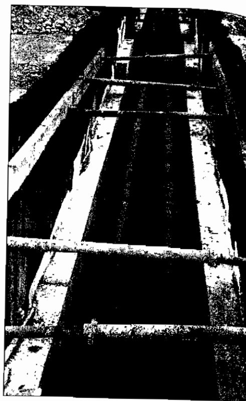
Photo 6.22 • Réseau de chauffage centralisé – Pose des canalisations dans un caniveau.
