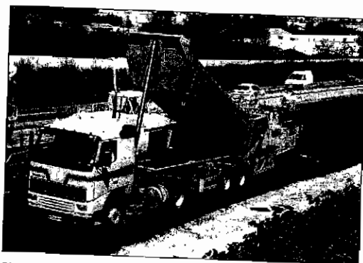
Photo 4.8 • Mise en œuvre de la couche de roulement en béton bitumineux.
