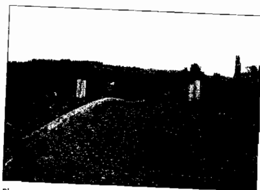
Photo 4.7 • Mise en place de la couche de base en matériaux concassés.
