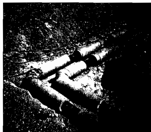
Photo 6.23 • Réseau de chauffage centralisé - Canalisations pré-isolées.
