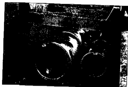
Photo 5.1 • Assainissement de type séparatif – Canalisations en béton armé – EP DN 1 200 mm, EU DN 800 mm.
