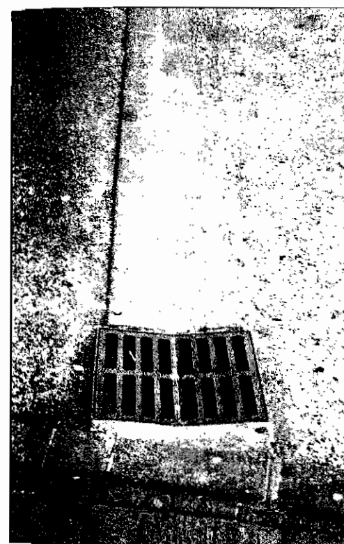
Photo 5.7 • Caniveau central ouvert à double pente.
