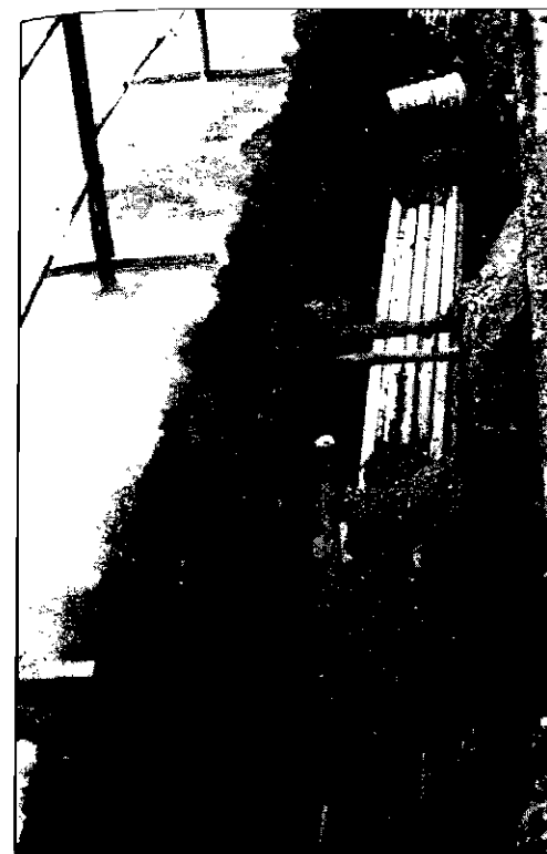
Photo 6.16 • Pose de fourreaux pour lignes téléphoniques.
