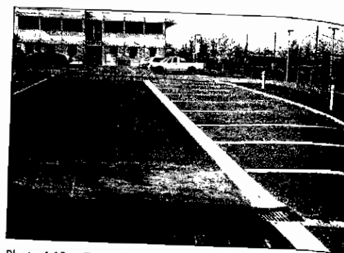
Photo 4.12 • Zone de stationnement – Revêtement en alvéoles creuses en PVC.
