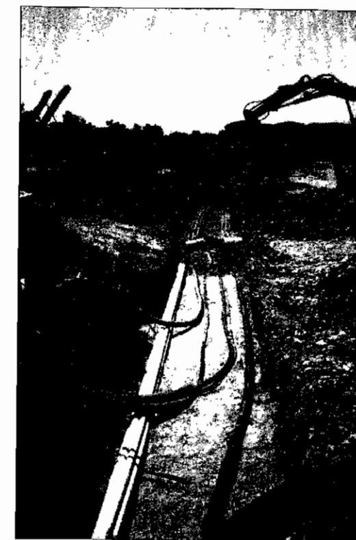
Photo 9.3 • Pose de câbles et de canalisations dans une tranchée commune.
