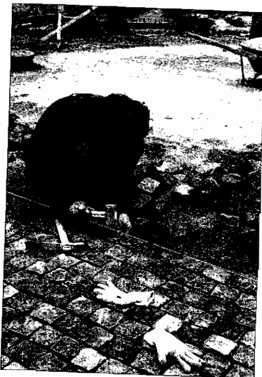
Photo 4.9a • Pose au cordeau à joints croisés de pavés de granite.
