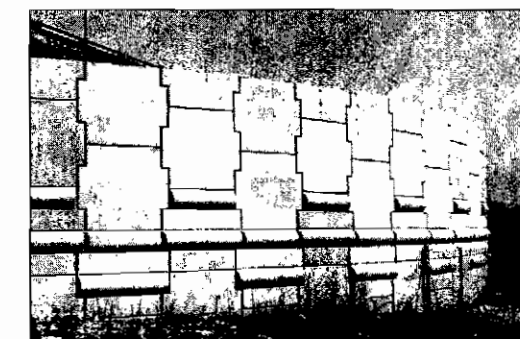
Photo 7.3 • Plaques de parement d'un massif de soutènement en terre armée.
